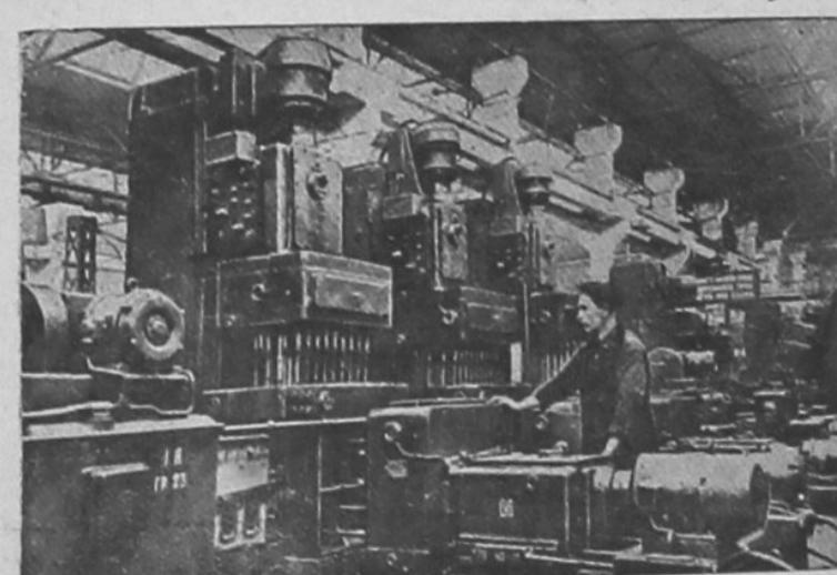
На Ярославском автомобильном заводе обработка всех основных деталей для дизельных моторов переведена на поточный метод. На участке блока цилиндров создана автоматическая линия, позволившая в несколько раз увеличить выпуск продукции.
